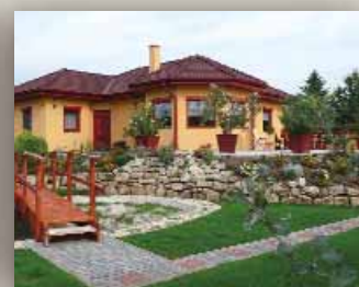
Készház épület, I. helyezés Tetőfedő: Trend-Haus Hungária Kft., Sopron Alpesi Protector tetőcserép
