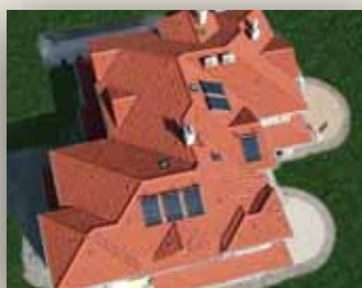
Új építés családi ház, I. helyezés Tetőfedő: Baksa Bt., Baksa Ferenc, Budapest Római tetőcserép
