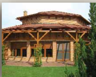
Új építés családi ház, III. helyezés Tetőfedő: Szűcs Sándor, Mórahalom Római Protector tetőcserép
