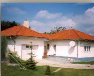
Felújított épületek, Különdíj Tetőfedő: Forrai György, Erdőkertes Római tetőcserép
