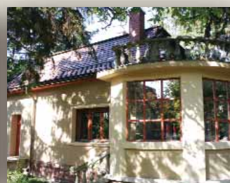
Felújított épületek, II. helyezés Tetőfedő: Tető-Profi Kft., Tárai Tamás, Veszprém Hód farkú betoncserép
