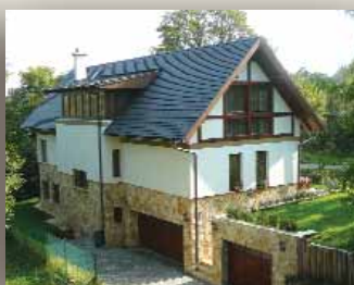
Új építés családi ház, II. helyezés Tetőfedő: Esi Bt., Simon Imre, Sopron Téglány betoncserép
